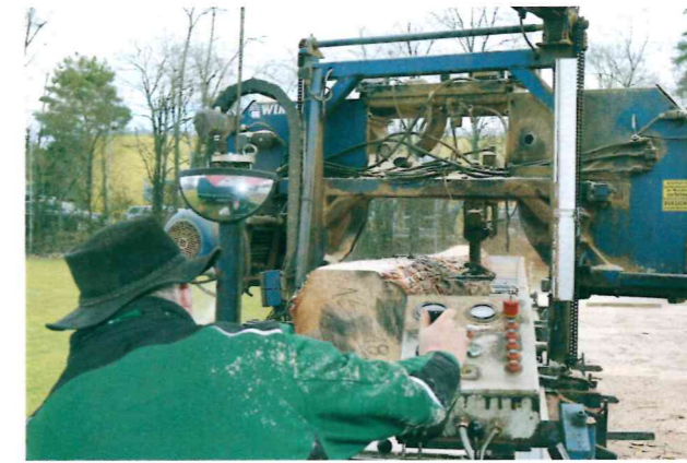
Abb. 5: Holz wird für den Bau zugesägt.
